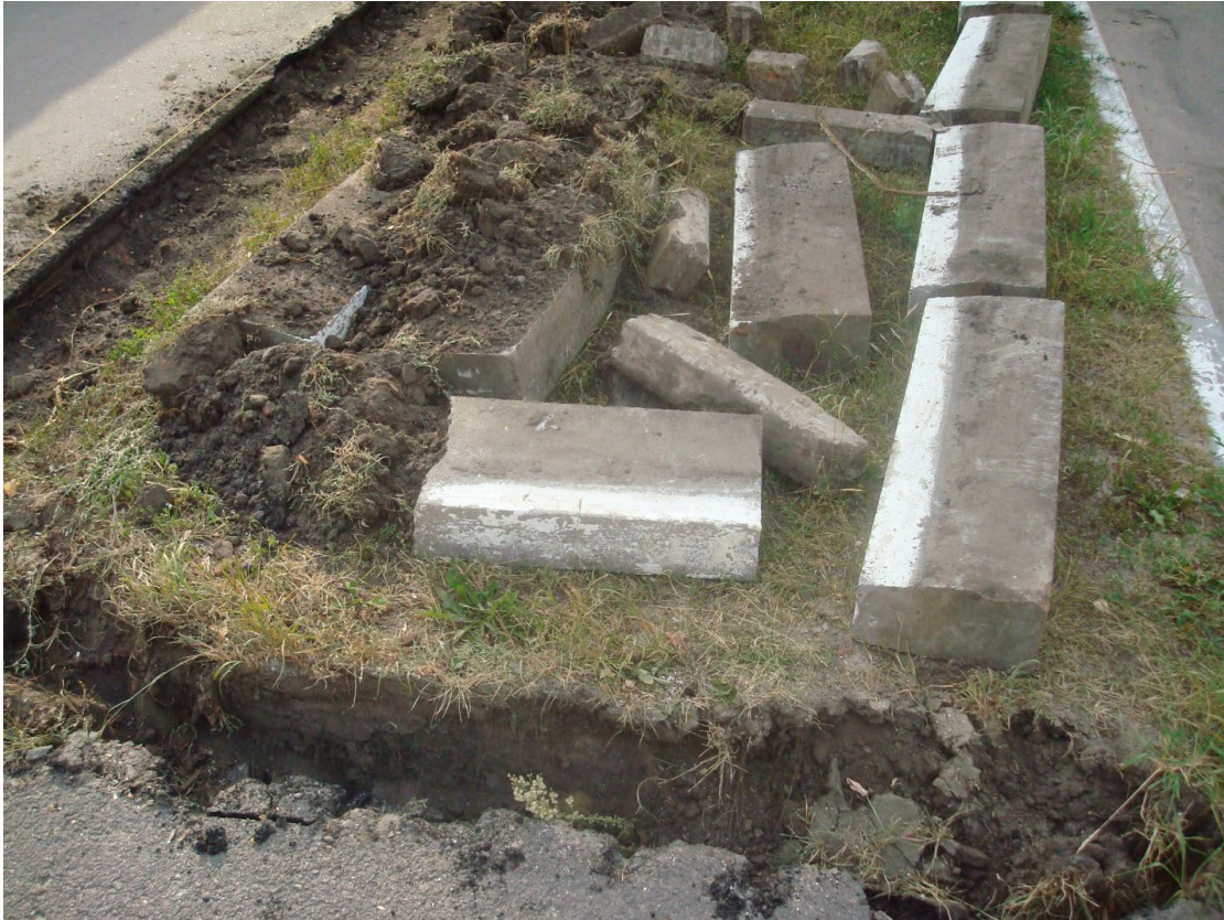
Рис. 1. Технология укладки тротуарной плитки и бордюрного камня (фото автора)
