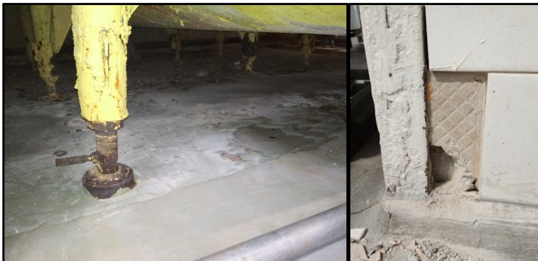
Рис. 5. Состояние пола (слева) и колонны (справа)
