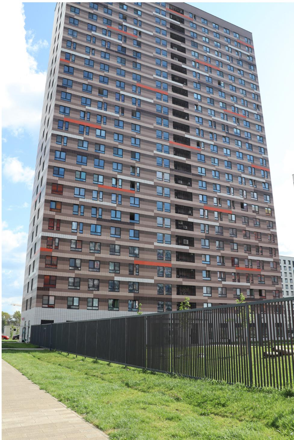
**Рис. 4.** Жилой дом, в котором внешние блоки систем кондиционирования воздуха размещены в специальном помещении (полукрытая шахта в середине здания)
