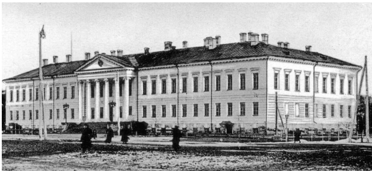
Рис. 3. Здание губернского управления в г. Томске
