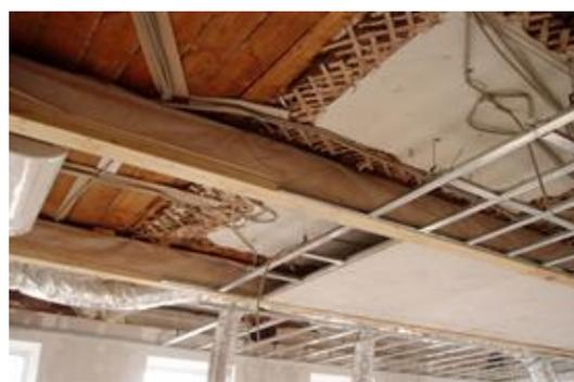
**Рис. 8.** Балочный тип деревянного перекрытия
