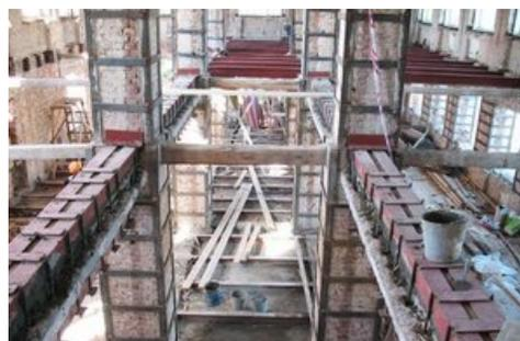
**Рис. 6.** Вертикальные несущие конструкции
