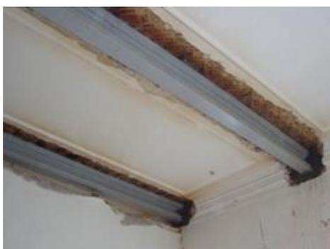
**Рис. 7.** Балочный тип металлического перекрытия
