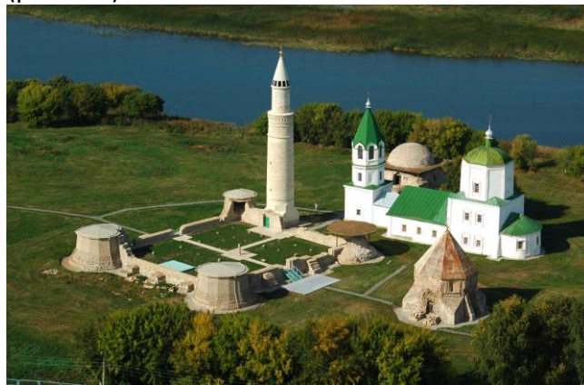
Рис. 1. – Панорама комплекса сооружений Великого Булгара: слева – реконструкция Соборной мечети и Большого минарета, справа – Северный мавзолей (XIV в.); на втором плане справа – Церковь Успения (XVIII в.) 2
