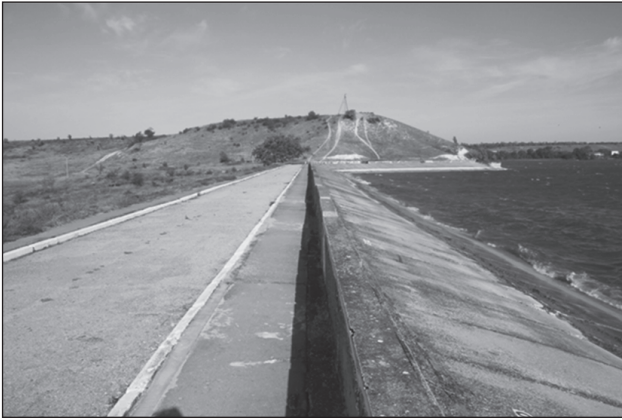
Рис. 3. Гребень грунтовой плотины Альминского водохранилища
