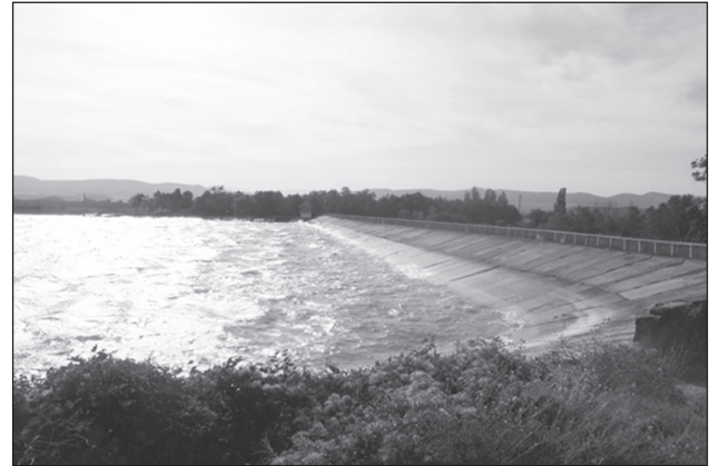
Рис. 2. Вид на плотину со стороны верхнего бьефа
