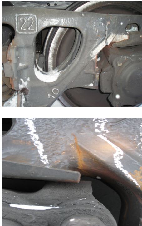
Рис. 1. Усталостные трещины в зоне радиусом R55 буксового проема боковых рам в эксплуатации
