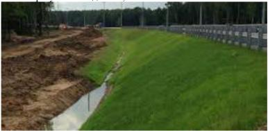
Рис. 1. Укрепление насыпи засевом трав
