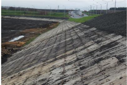
Рис. 4. Укрепление насыпи бетонными плитами
