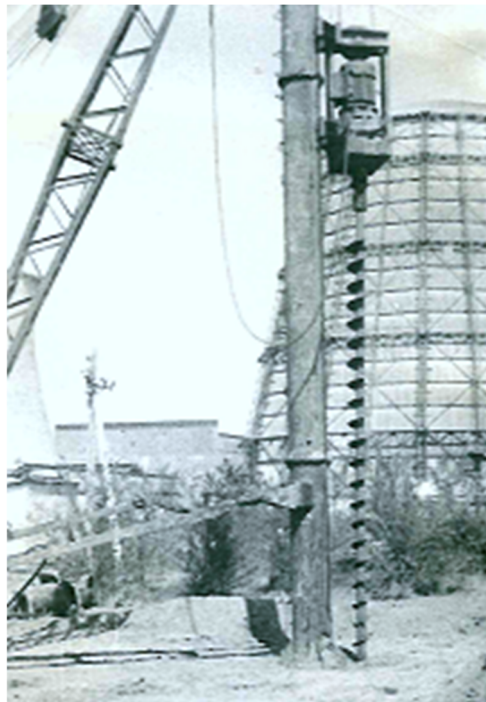
Рис. 3. Бурильная установка БУК-600 с буровым коническим ставом (шнеком)
