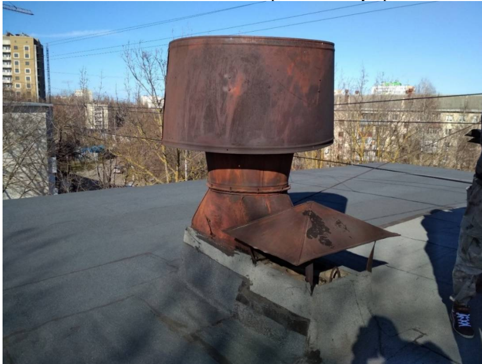
Рис. 3. Выход вентиляционных шахт и дымоходов на крыше
