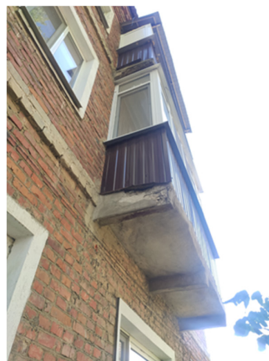
Рис. 2. Состояние балконных плит кв. 3 (слева) и кв. 4 (справа)
