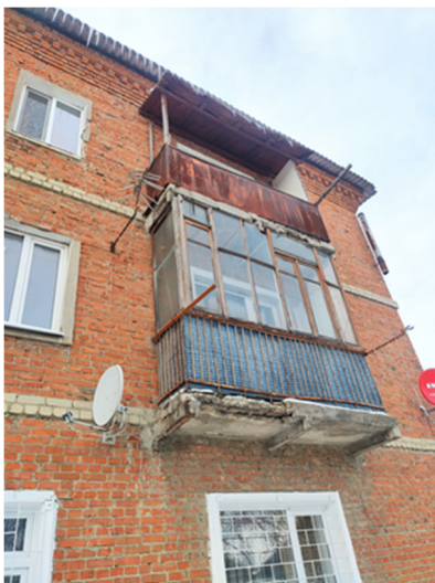
Рис. 1. Состояние балконных плит кв. 1 (слева) и кв. 2 (справа)
