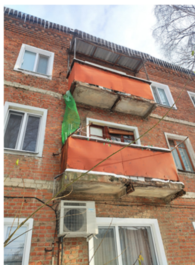
Рис. 3 Состояние балконных плиты кв. 5 (слева) и кв. 6 (справа)
