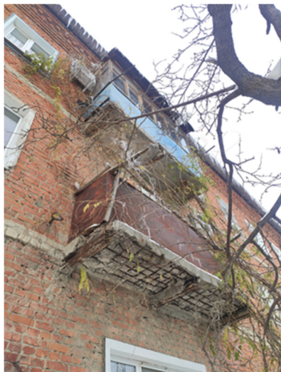
Рис. 2. Состояние балконных плит кв. 3 (слева) и кв. 4 (справа)
