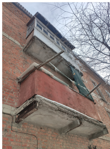
Рис. 1. Состояние балконных плит кв. 1 (слева) и кв. 2 (справа)
