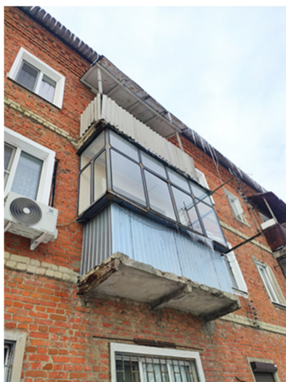
Рис. 3 Состояние балконных плиты кв. 5 (слева) и кв. 6 (справа)
