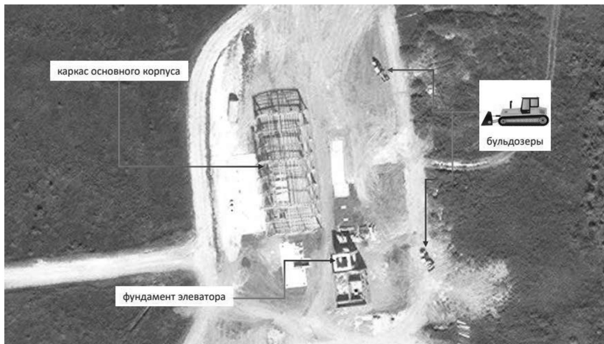
Рис. 3. Пример мониторинга строительства элеватора (на примере материала АО «Терра Тех»)
