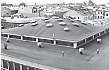
Рис. 8. Пологое железобетонное покрытие Некрасовского (Мальцевского) рынка, СПб.
