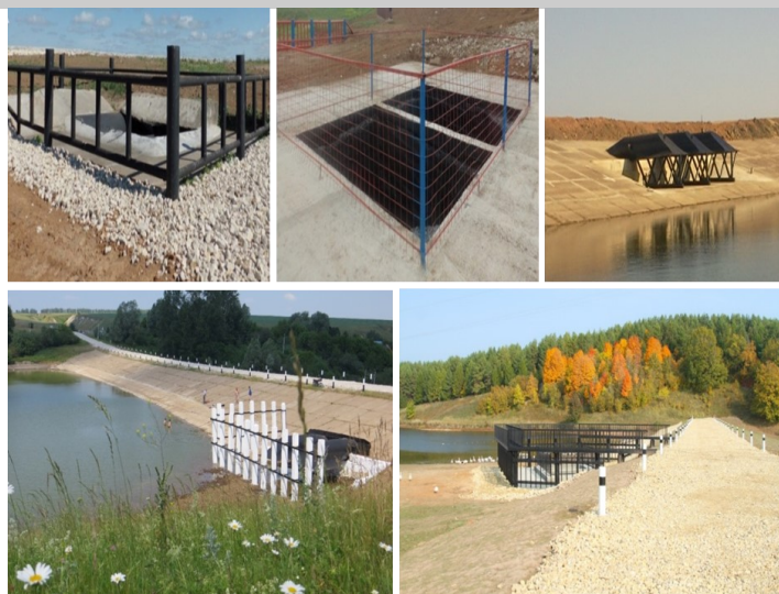
Рис. 1 – Гидротехнические сооружения в Республике Татарстан
