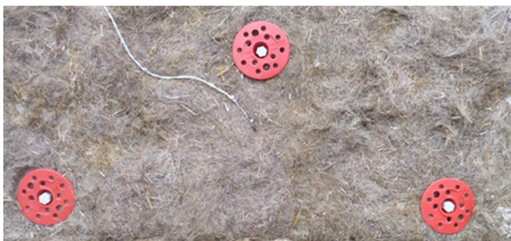
Рис. 9. Монтаж утеплителя на кирпичной стене
