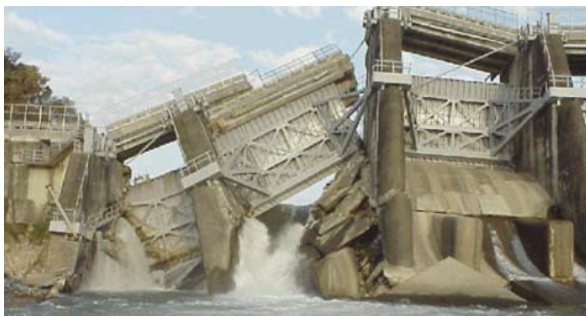
Рис. 3. Разрушение плотины Ши-Кань на Тайване во время землетрясения Чи-Чи 21.09.1999 г [9]
