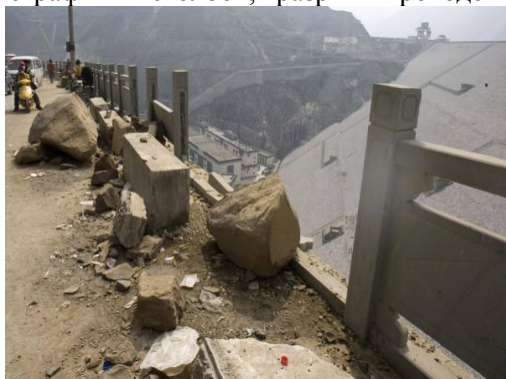
Рис. 4. Фрагменты повреждения плотины «Зипингпу» во время землетрясения [9]
