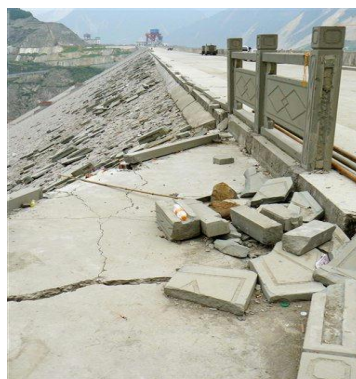
Рис. 4. Фрагменты повреждения плотины «Зипингпу» во время землетрясения [9]
