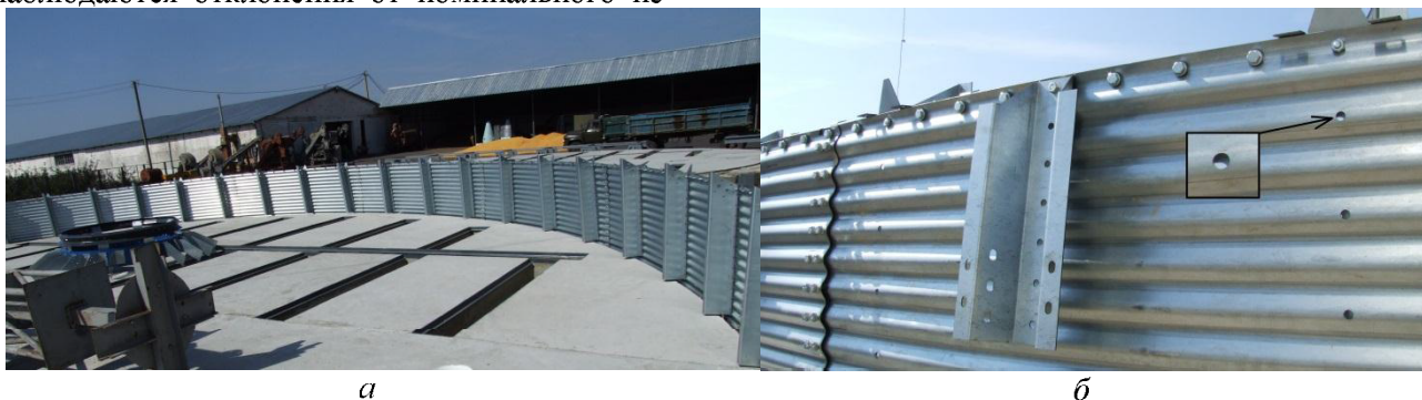
Рис. 1. Сборка силоса: а – цилиндричность конструкции; б – concentричность отверстий
