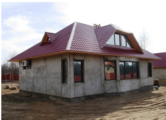
Рис. 2. Возведение малоэтажного здания из монолитного железобетона
