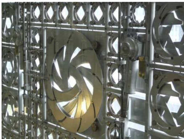
Рис. 14. Жан Нувель. Механизм кинетического орнамента и фасад Института арабского мира. Париж, 1987
