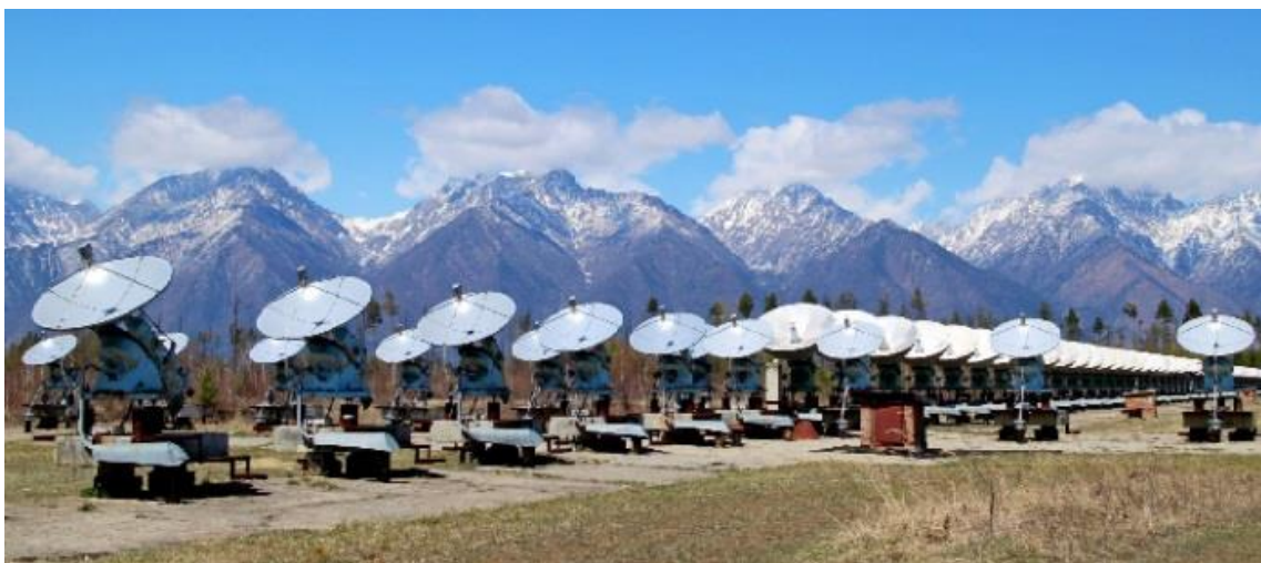
Рис. 1. Центральная часть антенной решетки СРГ и северный луч ССРТ
