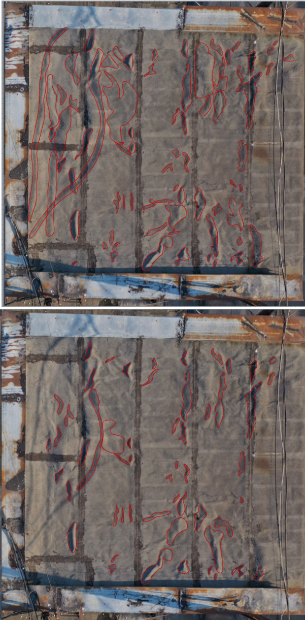
Рис. 1. Дефект «Вздутие», определенный разными экспертами
