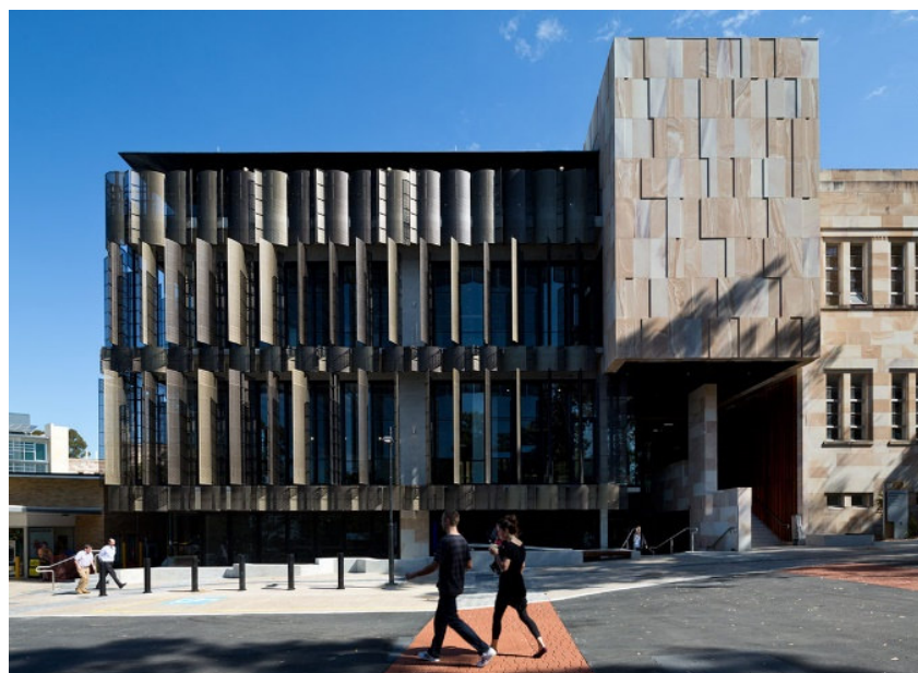
Рис. 5. Первое здание из геополимербетона на основе золы-уноса, Университет Квинсленда, Австралия
